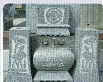
ペイントの剥がれ
